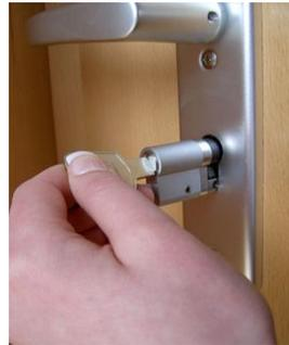
um den Schließzylinder einfach herauszuziehen. Sollte der Schließzylinder etwas festgesetzt sein, hilft ein leichtes rütteln beim Herausziehen
