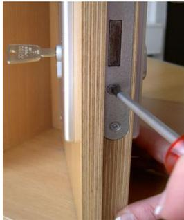
diese lösen Sie (in den meisten Fällen mit einem Kreuzschlitz-Schraubenzieher)
